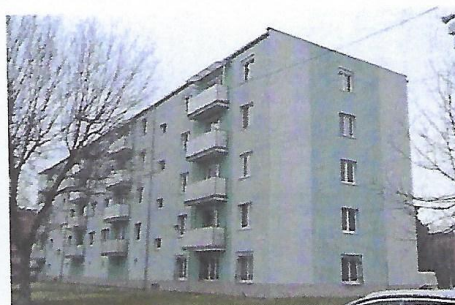
Pohľad na juhozápadné nárožie
