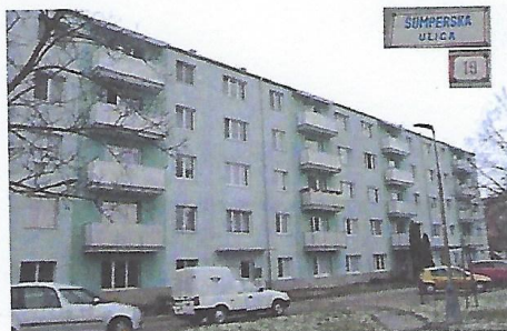
Pohľad na východnú fasádu
